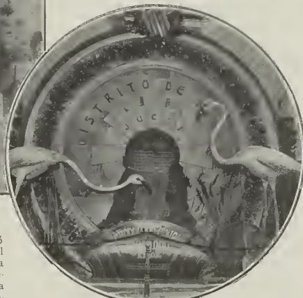
Instalación del Ayuntamiento de Sueca en el Pabellón de Agricultura (De fotografías de F. Moya.)
